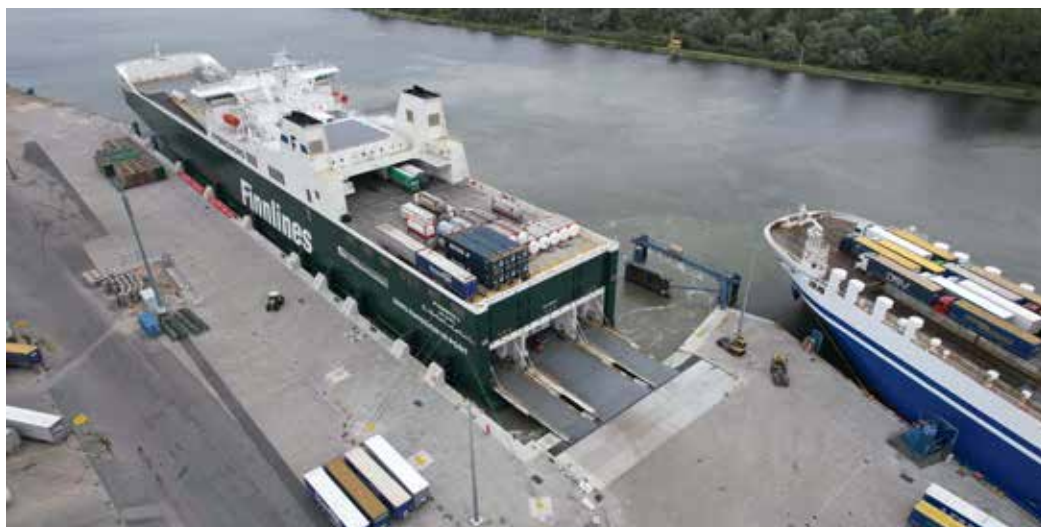
Am neuen Anleger 5 am Skandinavienkai können RoRo-Schiffe bis zu 250 Meter Länge abgefertigt werden
